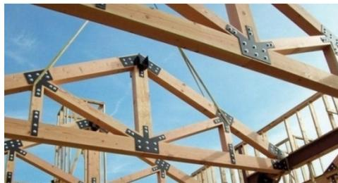
Жёсткость конструкции обеспечивают составляющие её треугольники.
